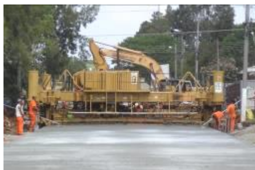
Figura 10. Pavimentadora de forma deslizantes - marca TEREX CMI.
