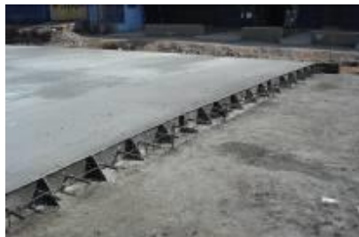
Figura 14. Junta transversal de construção.
