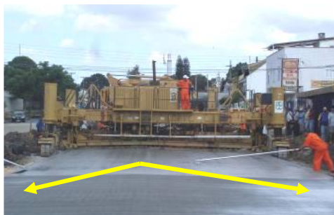
Figura 11. Duplo caimento da pista – largura de 8,70m
