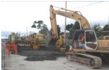
Figura 12. Distribuição do concreto com o auxílio de escavadeira
