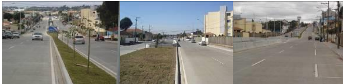
Figura 16. Panorama da Avenida Santa Bernadethe após a conclusão das obras.
