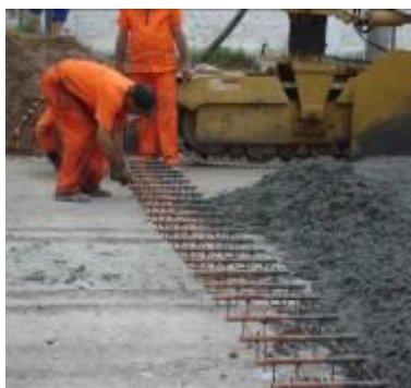
Figura 13. Sistema de apoio das barras de transferência.
