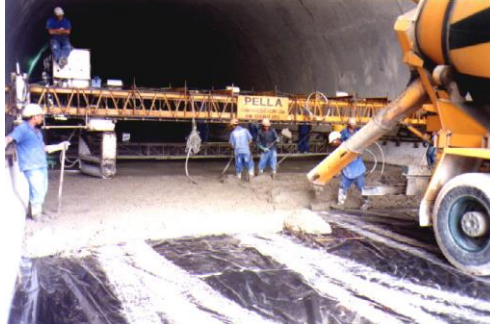
Figura 3.4 – Lançamento do concreto
