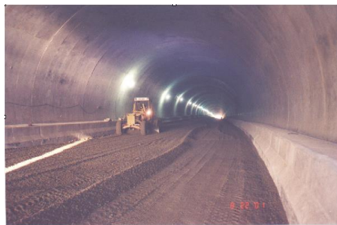
Figura 3. 2 - Espalhamento do CCR com Motoniveladora
