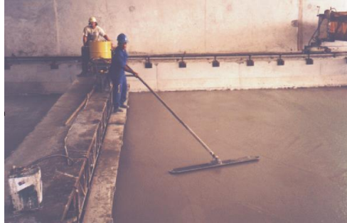
Figura 3.7 – Acabamentos manuais
