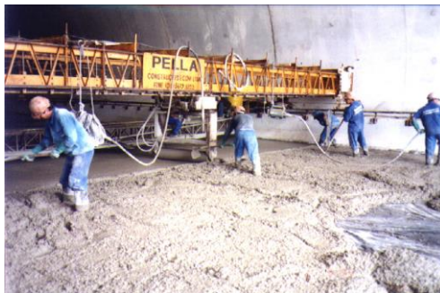
Figura 3.5 – Vibração do concreto
