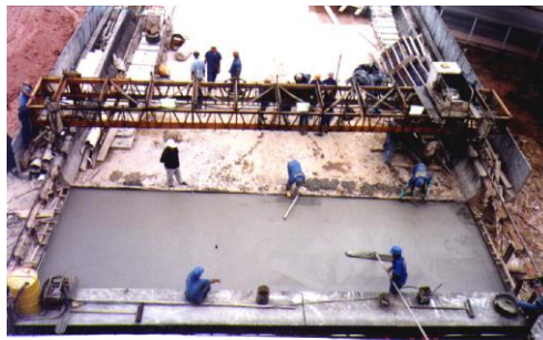
Figura 3.6 – Deslocamento da forma-trilho
