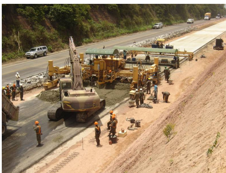
Figura 5. Execução do pavimento de concreto
